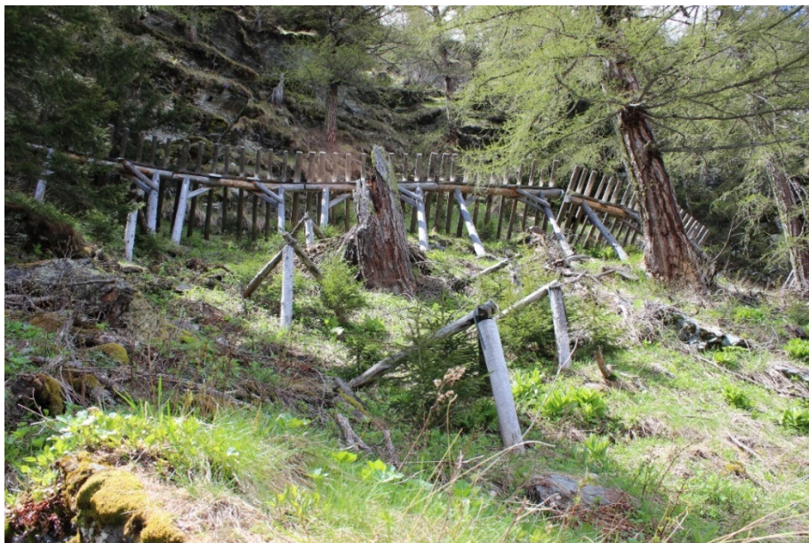
Situation im Baholz heute: Lawinenwerke und aufkommende Verjüngung.
