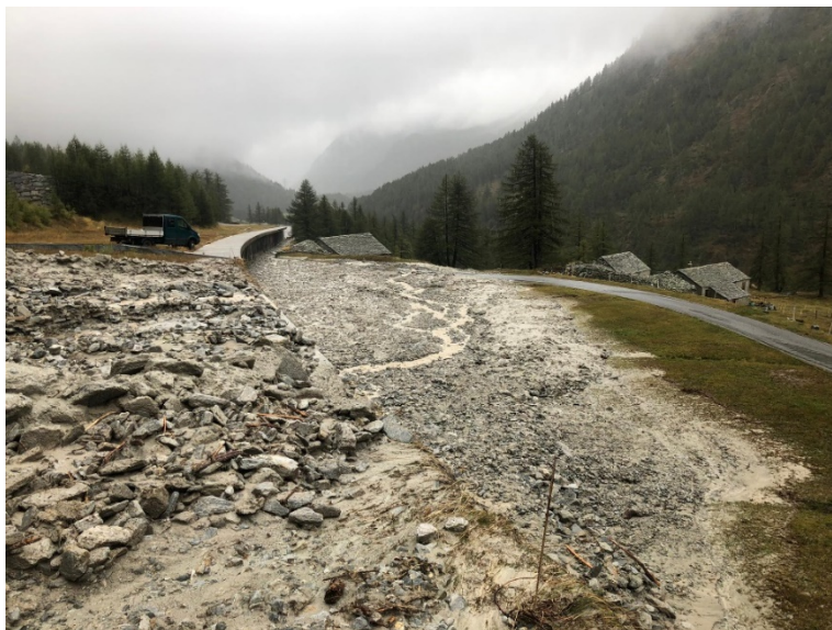
Abbildung 1 Murgang "Engi" Oktober 2020- durch direktes Eingreifen von Arbeitskräften wurde das Ausmass der Schäden gemildert
