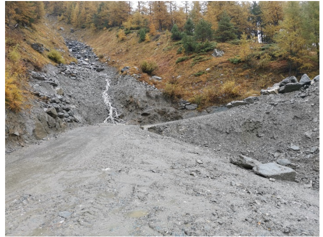
Abbildung 4 Alpjerstrasse "Wyssgrabu" 2020 - Schäden beseitigt durch die Zenklusen Bau AG
