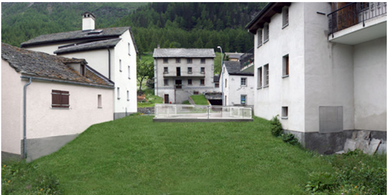
Neuer Zustand Einfahrt Parkgarage
