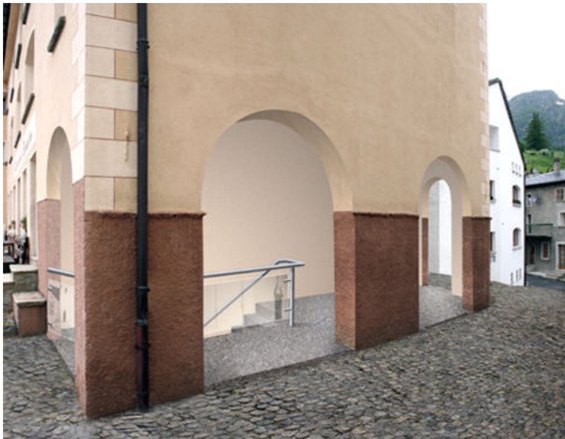
Restaurierter einstiger Zustand als Ausgang Parkgarage
