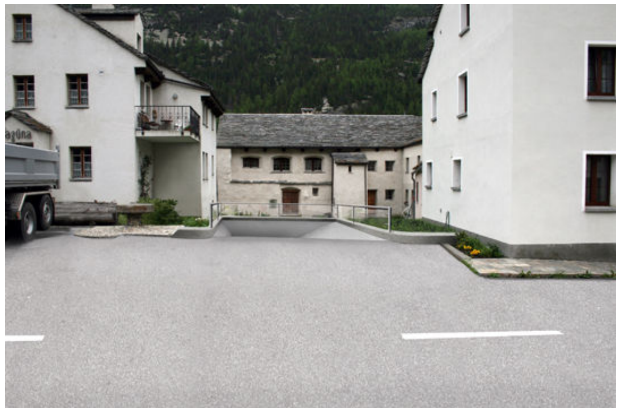
Neuer Zustand Einfahrt Parkgarage
