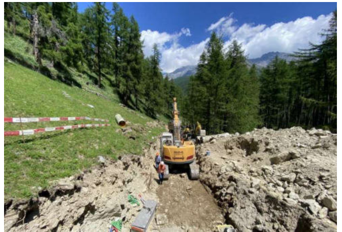
Die Zuleitung von der Wasserfassung Sengibach zum Ausgleichsbecken Egga wurde ersetzt.
