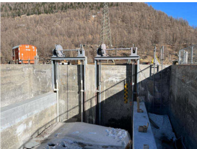
Beim Ausgleichsbecken in der Egga wurde der Überlauf saniert und der Grundablassschieber erneuert.
